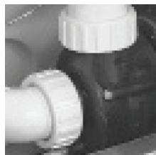
Nehmen Sie eine Entlüftung vor, indem Sie die Pumpenanschlüsse leicht öffnen.
